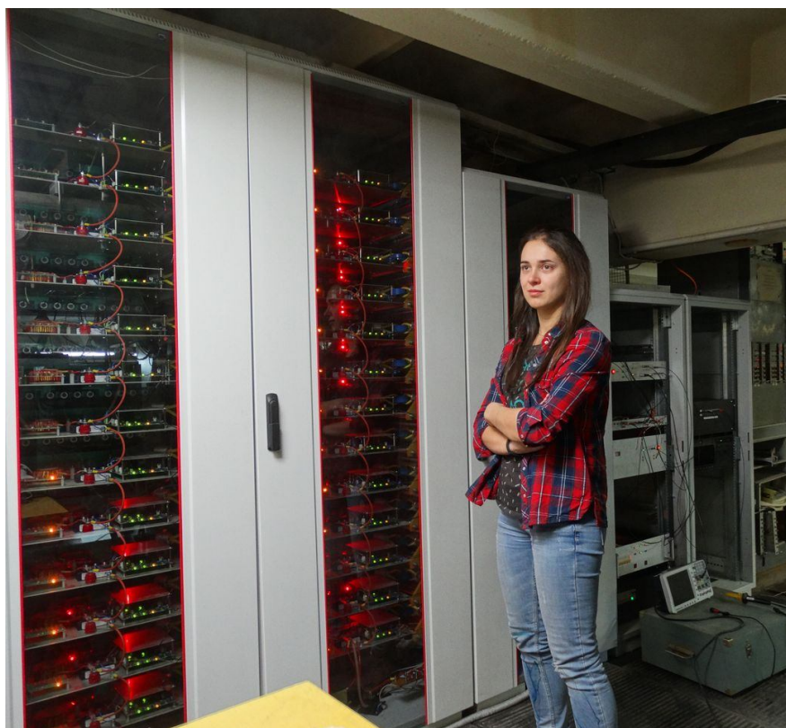
Рисунок 4 - Система питания атомарного инжектора №2 на установке ГОЛ-3.
