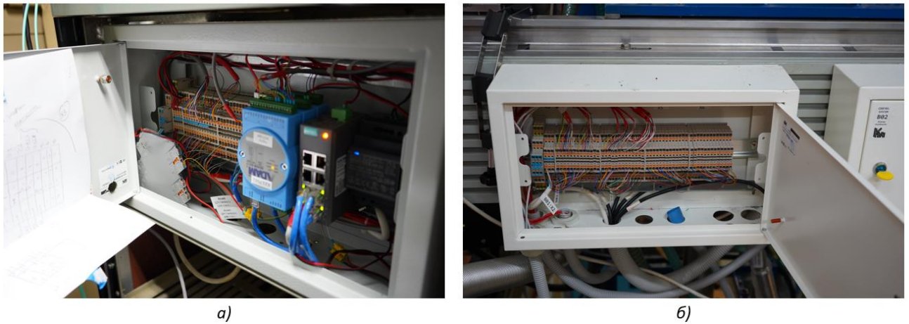
Рисунок 46. Монтаж в коробах внутри установки: а) первая версия с устройствами ввода-вывода; б) вторая версия без устройств ввода-вывода.
