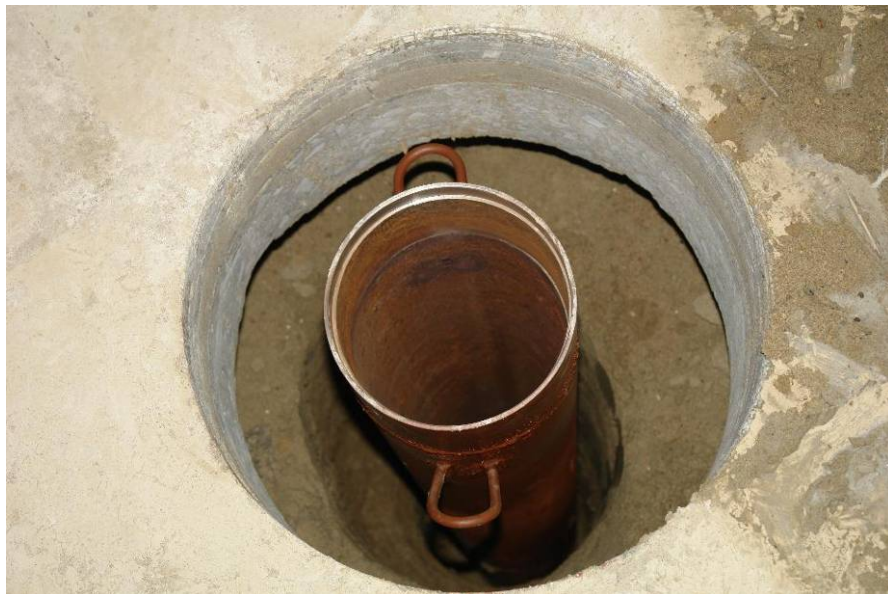
Рис. 115. Фотографии этапа монтажа заглубленного защитного контейнера для выдержки и временного хранения активированных мишеней.
