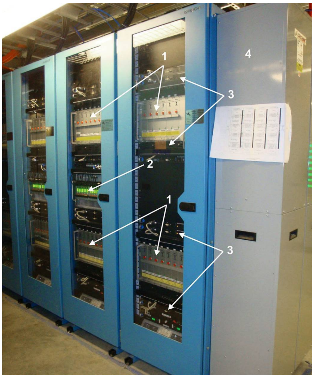
Рисунок 2: Радиостойки RGC2, RGC3, RGC4 с источниками питания корректоров:
