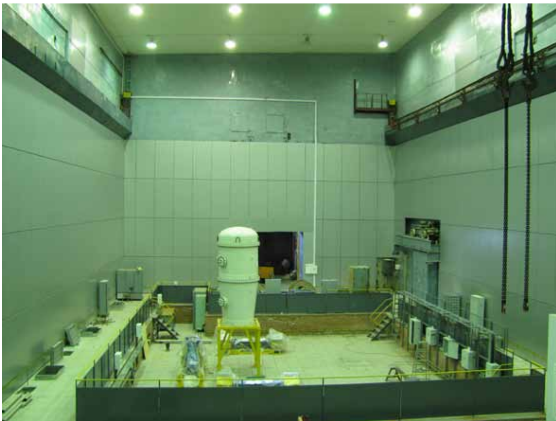
Рис.(5.7)1. Начало монтажа охладителя в зале для испытаний.
