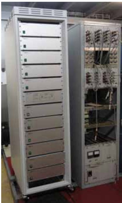
Рис.(5.3)9. Новая стойка питания магнитоэлектронных насосов каналов ИК.
