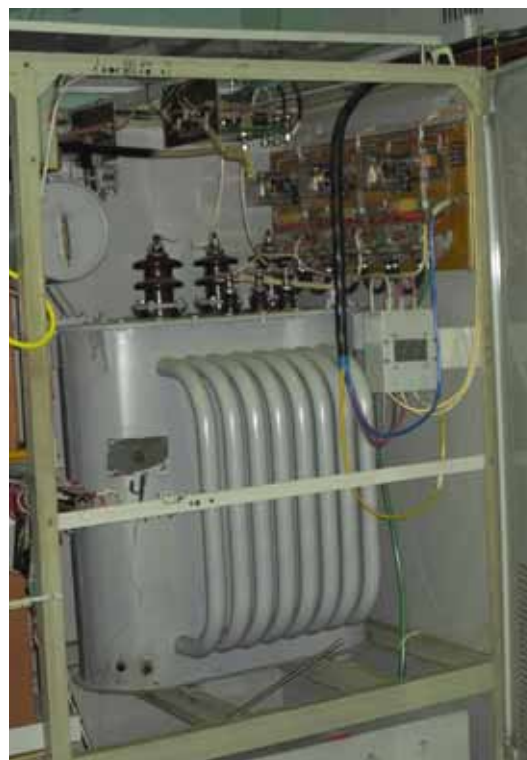
Рис. (5.11) 4. Высоковольтный регулируемый выпрямитель мощностью 100 кВА.
