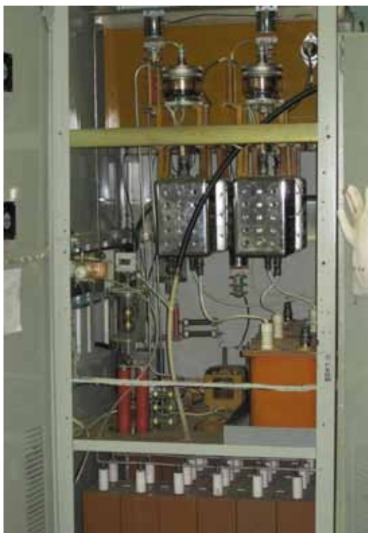
Рис.(5.11) 3. Анодный модулятор.
