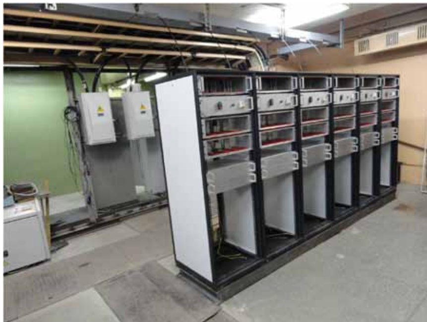
Рис.(5.3)11. Стойки импульсного питания для элементов канала ИК.
