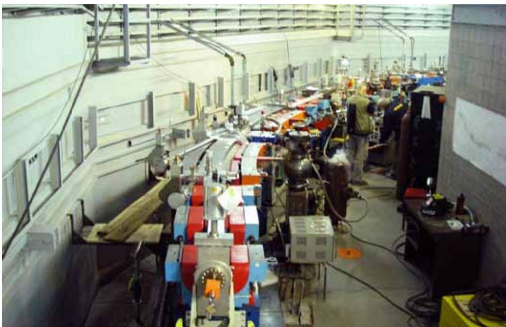
Рис.(6.5)3. Рабочий момент монтажа вакуумной системы большого кольца источника СИ “Зеленоград”.
