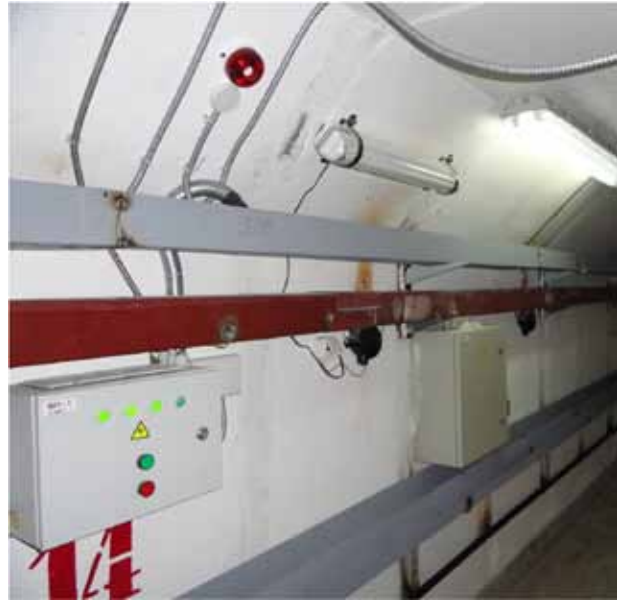
Рис.(5.3)7. Элементы системы пожарной сигнализации в канале ИК.
