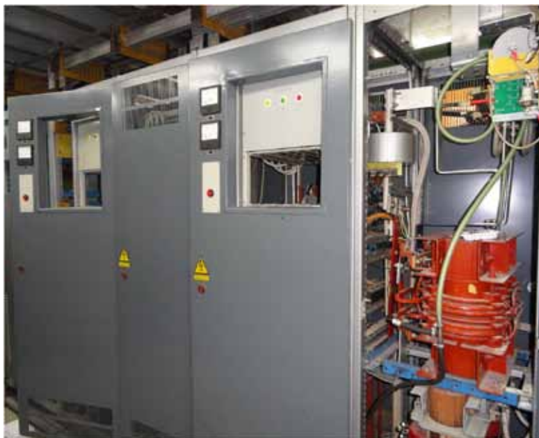
Рис.(5.3)10. Реверсивные ИСТы для спуска в канал ИК.
