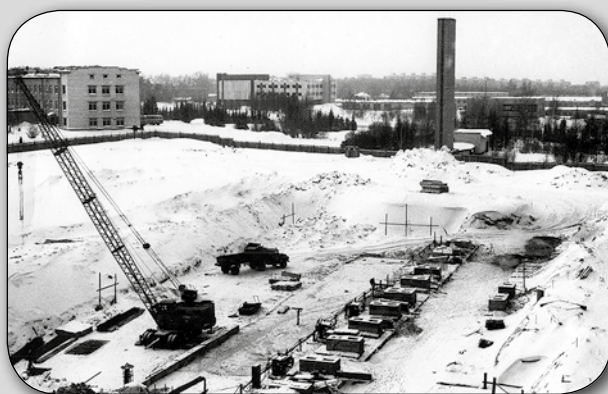
Этапы строительства здания ДОЛ. 02.1981 г.
