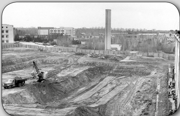
Котлован под ДОЛ. 10.1980 г.
