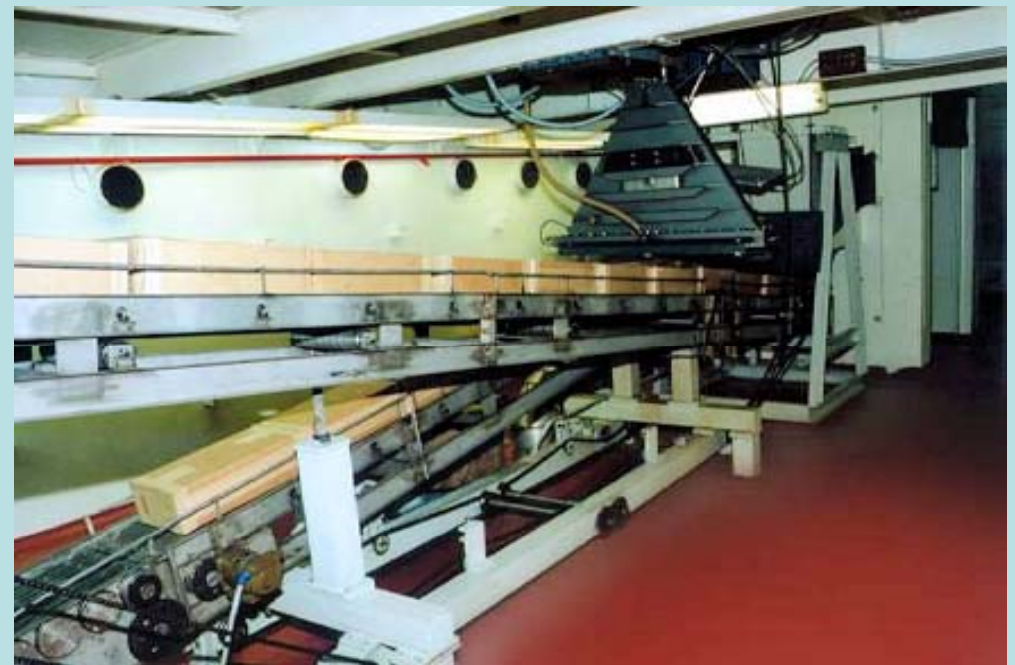
Комплекс по стерилизации одноразовых медицинских шприцов на основе ускорителя ИЛУ-6 (производства ИЯФ СО РАН) в г. Ижевск.
