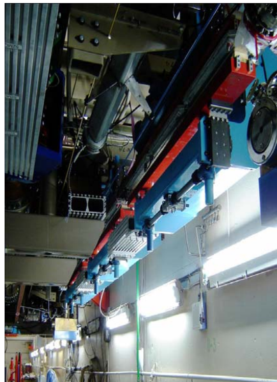
Рис. 6.4.6. Ондуляторы третьей очереди ЛСЭ, установленные на четвёртую дорожку УР.
