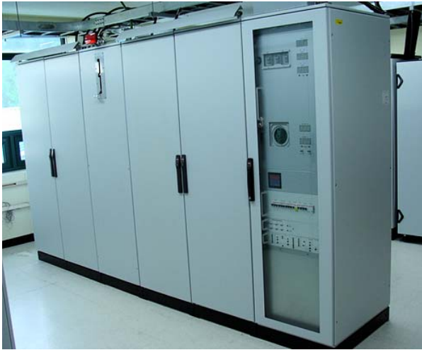
Рис. 7.11.1. Источник анодного питания 9,2 кВ, 45 А.
