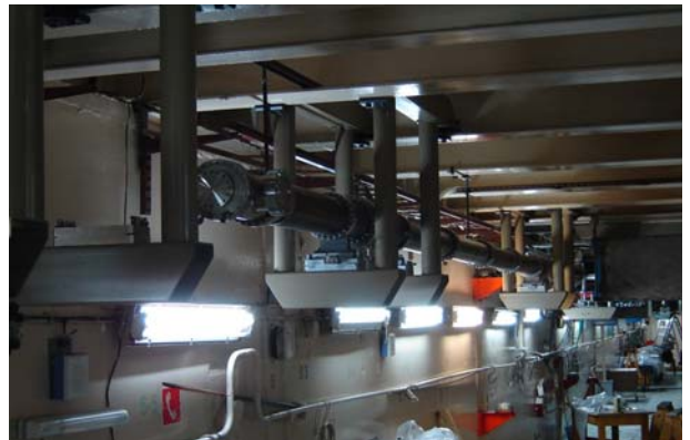
Рис. 6.4.3. Вакуумная камера оптического резонатора ЛСЭ третьей очереди, подвешенная в ускорительном зале.
