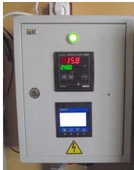
Рис.7.17.10. Новый контроллер печей.
