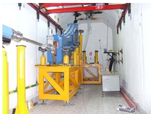
Рис. 5.1.6. Подъем инжекционного канала К-500.
