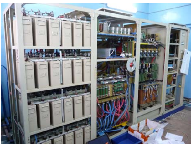
Рис. 8.1.2. Система питания ускорителя ИЛУ-10 для совместной лаборатории НГУ и ИЯФа.
