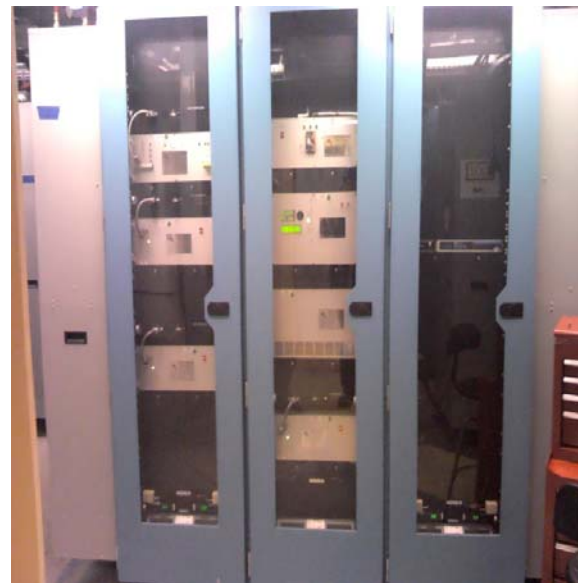
Рис. 7.1.2. Источники питания квадрупольей и DC – септума бустерного ускорителя NSLS-II.
