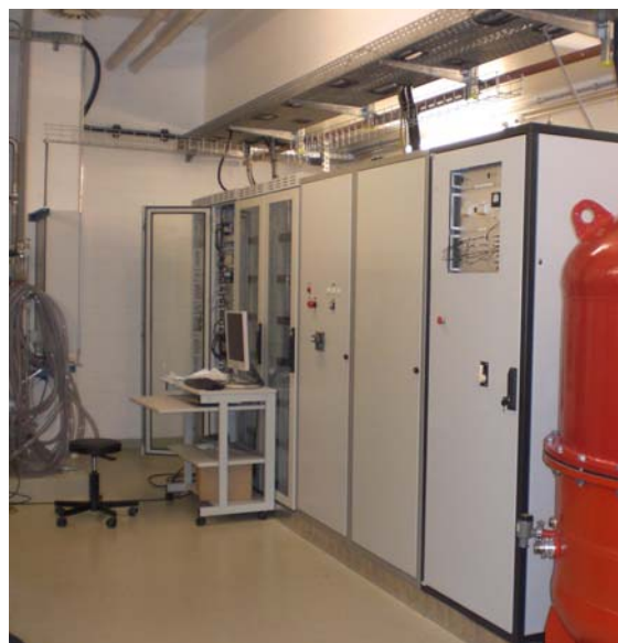
Рис.7.2.1. Источник высоковольтного питания диагностического инжектора RUDI-х.
