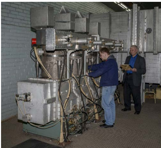
Рис. 7.5.1. Выходной четырёхмодульный каскад ВЧ генератора ВЭПП-4М .
