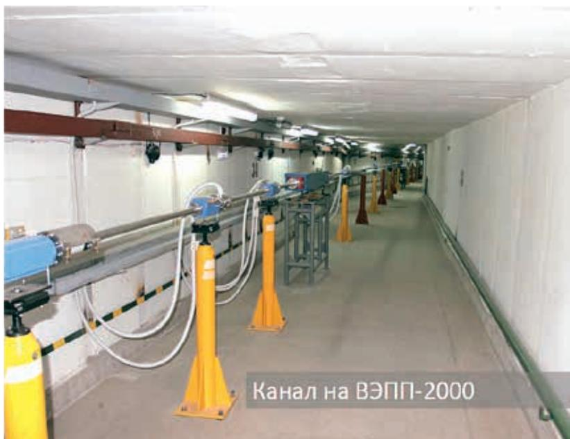
**Рис. 20.** Фрагмент прямолинейной части канала К2000 к коллайдеру ВЭПП-2000
