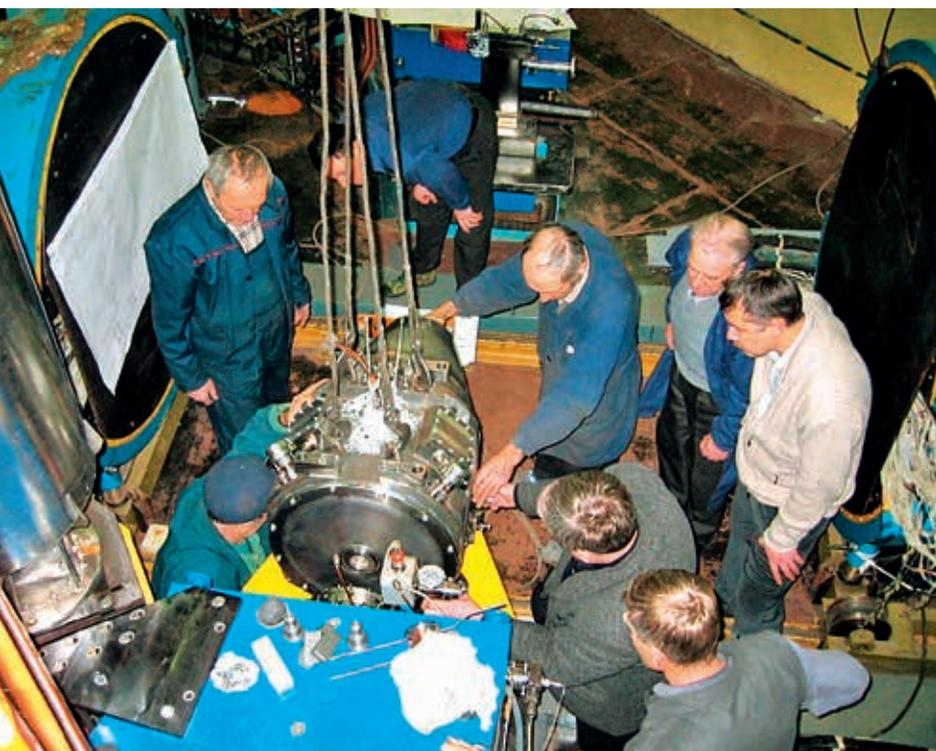
**Рис. 17.** Установка первого соленоида на кольцо, в промежутке СНД. М.И. Непомнящих, Е.М. Овчаров, А.А. Борисов, Н.А. Пимонов, А.В. Евстигнеев, А.А. Краснов, Ю.М. Шатунов, И.А. Кооп. 13.01.2006 г.
