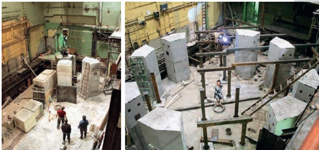
**Рис. 3.** Слева: завершается разборка основания ВЭПП-2М, залиты первые две колонны под магниты ВЭПП-2000, 14.05.2001. Справа: монтаж опор для детекторов и фальшпола, 17.07.2001
