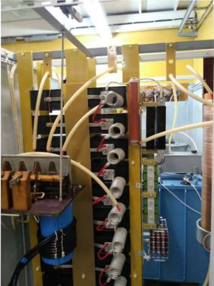
Высоковольтная часть модулятора
